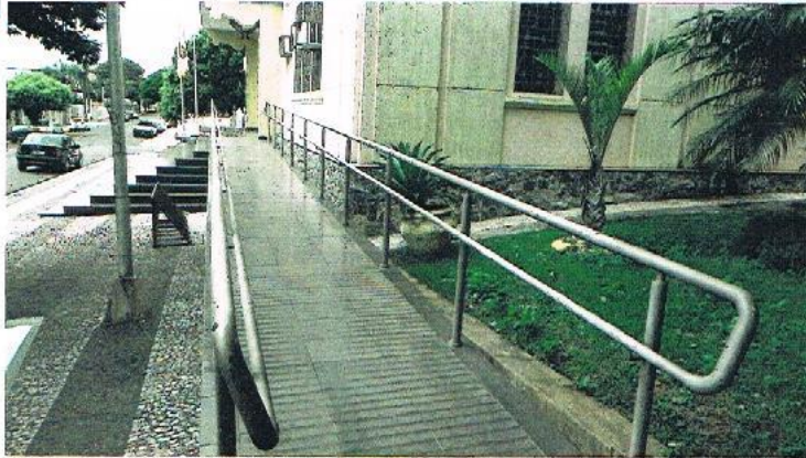
Foto 7- CORRIMÃO EM RAMPA DE ACESSO (25/02/2016)
