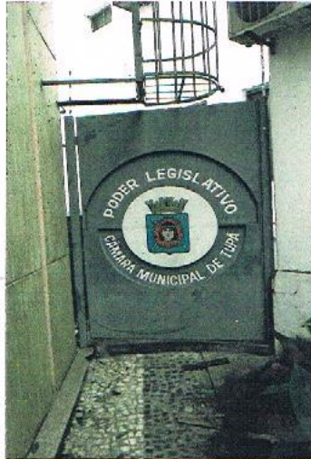
Foto 5 -PORTÃO NA LATERAL DIREITA DO PREDIO (25/02/2016)
