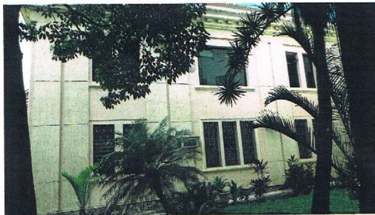
Foto 2 - VISTA LATERAL DO PREDIO LADO DIREITO (25/02/2016)
