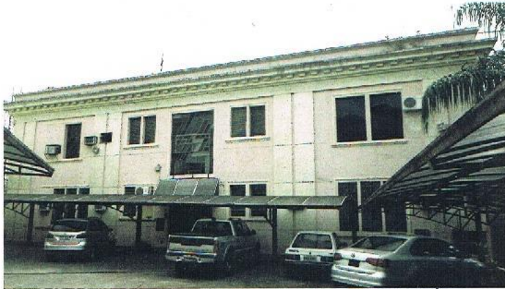
Foto 4 - VISTA DOS FUNDOS, ESTACIONAMENTO DO PRÉDIO
